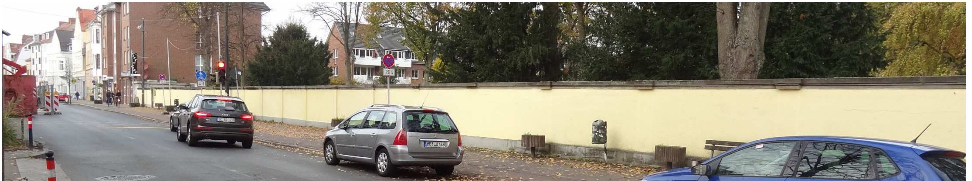
Friedhofsmauer Kornstraße Gegenwärtiger Zustand
