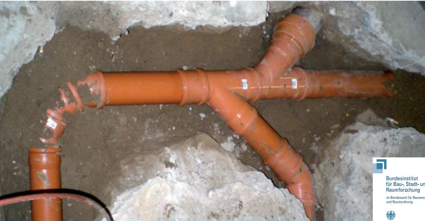
Aufwändige Erneuerung von Abwasserleitungen unter der Bodenplatte
