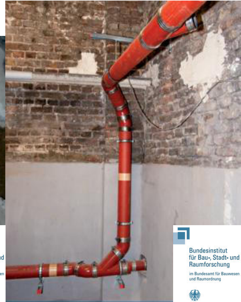
Abgehängte Leitungen an der Kellerwand
