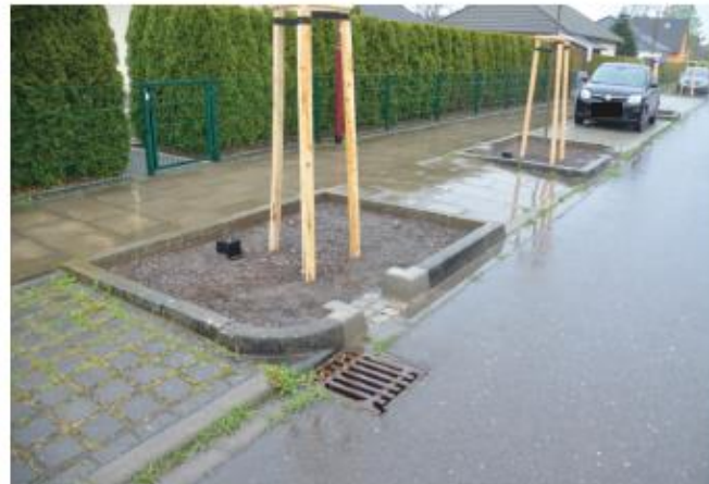
Abb. 9 - Hydrologisch optimierter Baumstandort, Lahnsteiner Straße, Neuenhagen bei Berlin [6]
