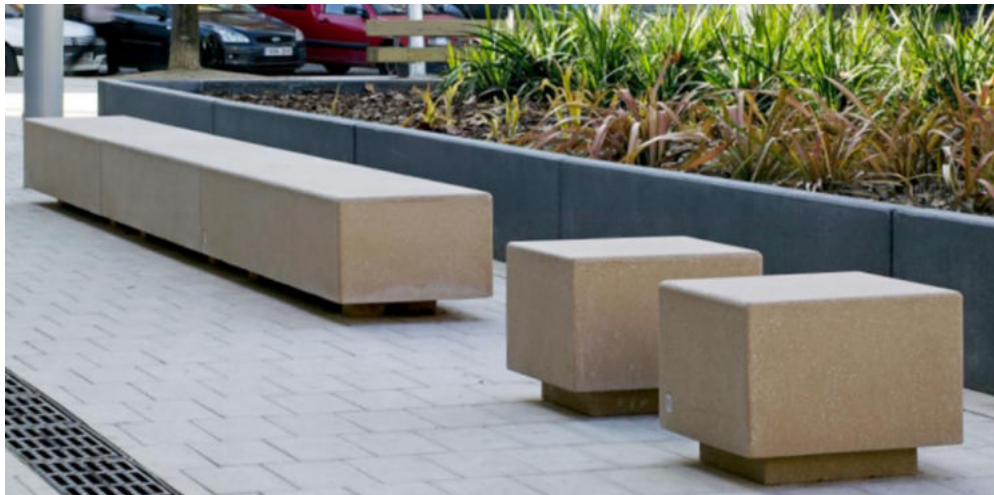
Sitzelemente aus Beton als Anfahrtschutz
